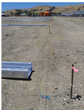
Ilustración 8 Replanteo de hincadas
