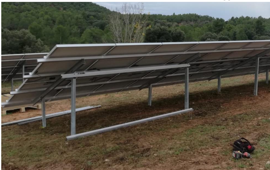
Ilustración 26 Perfiles para inversores
