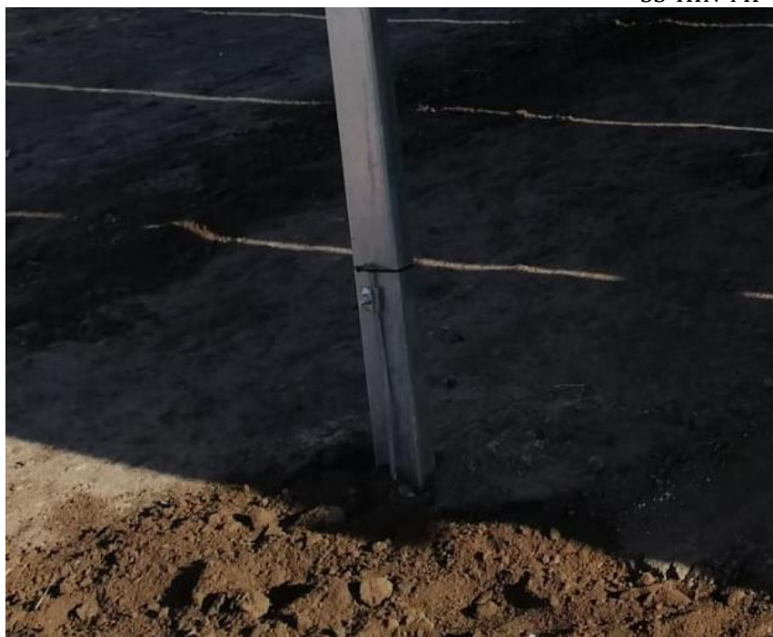
Ilustración 27 Conexión a tierra
