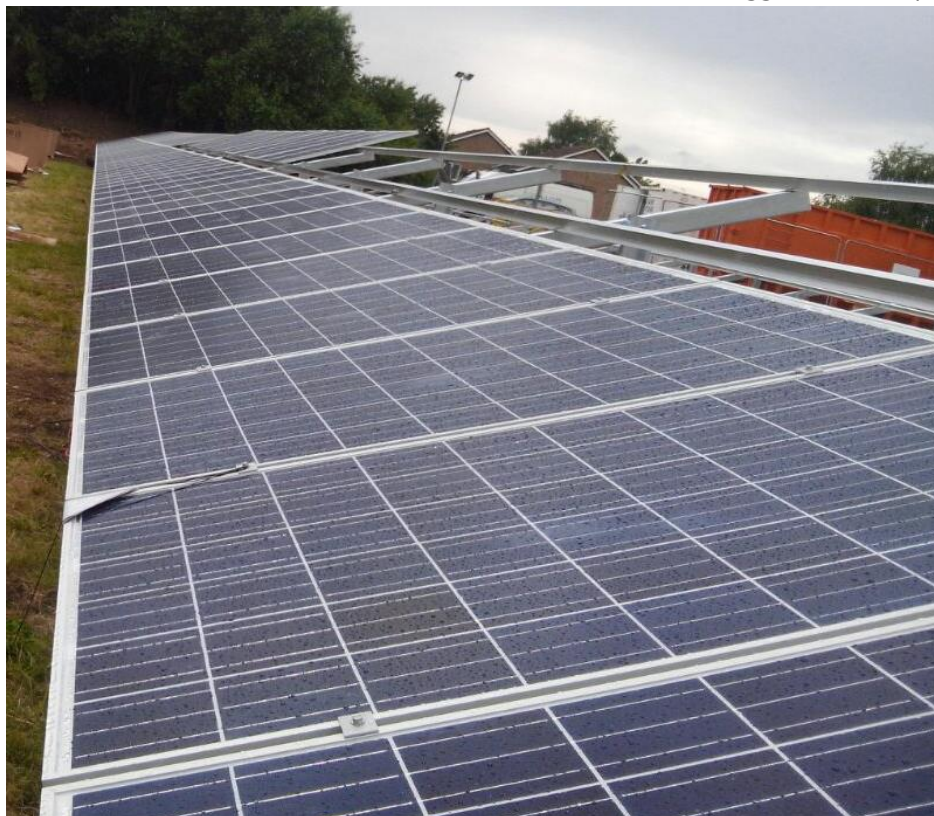
Ilustración 23 Mesa parcialmente montada
