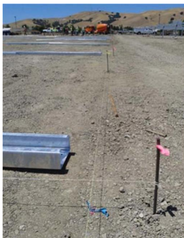
Ilustración 8 Replanteo de hincadas
