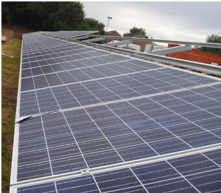
Ilustración 22 Mesa parcialmente montada
