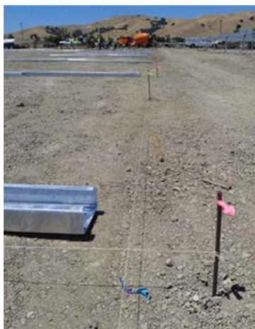
Ilustración 8 Replanteo de hincadas
