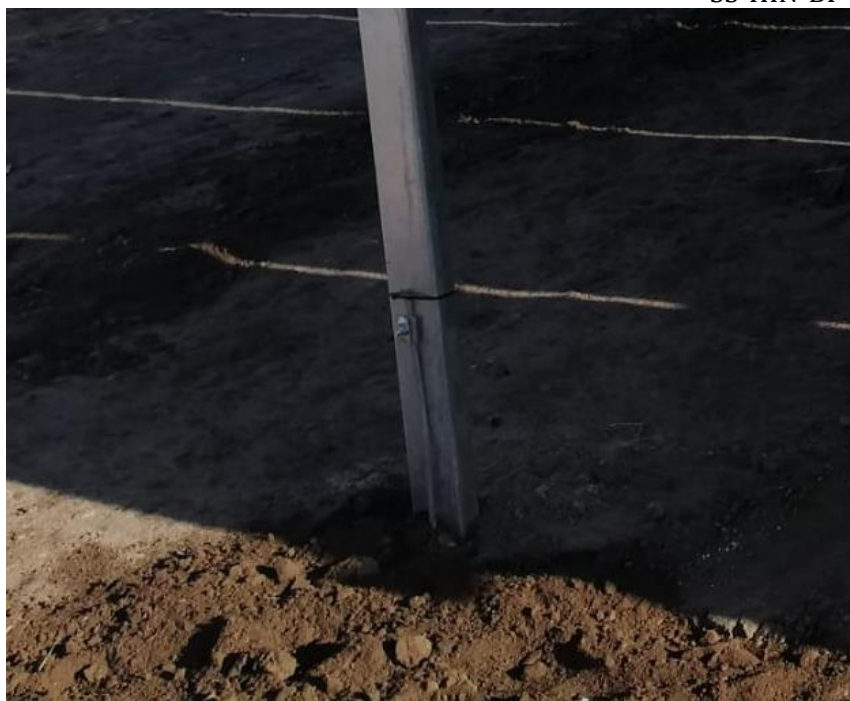
Ilustración 26 Conexión a tierra
